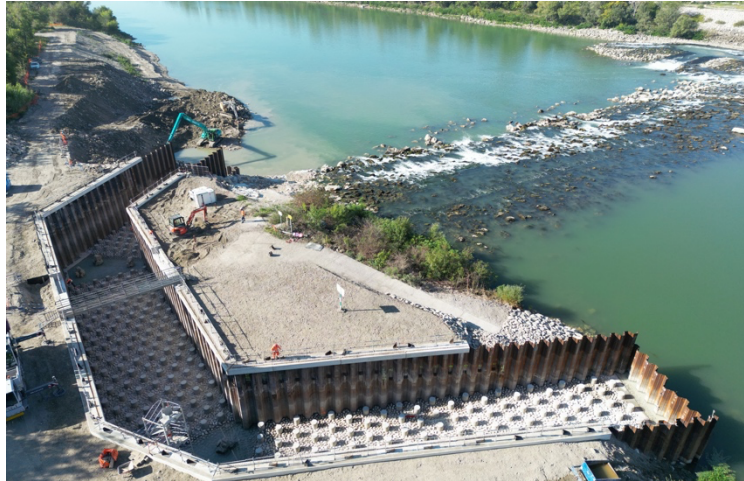
Figure 2 : Passe du seuil de Beaucaire – avant sa mise en eau
