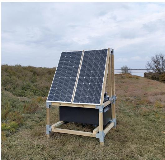
Figure 4 : Structure d'alimentation solaire pour les antennes RFID
