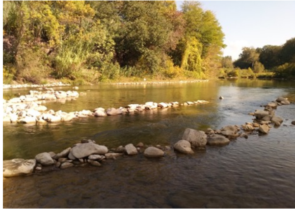
Figure 6 : Radier localisé en amont de la zone d'étude et présentant des enrochements artificiels formant un chenal drainant la majorité du débit
