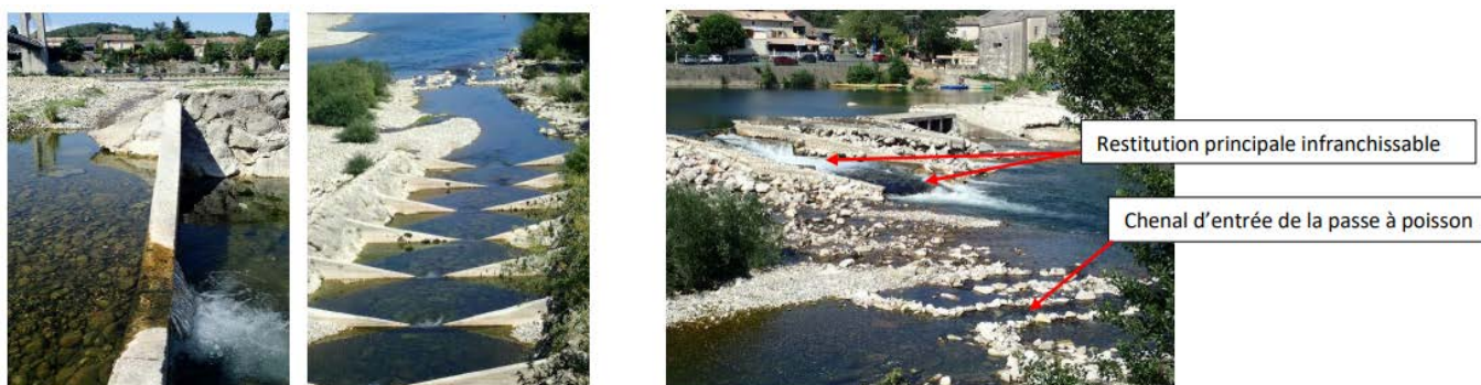
Figure 3 : De gauche à droite : Sortie de la passe à poissons / Vue générale de la passe depuis l'amont / Vue principale de l'entrée de la passe à poissons et de la principale restitution du seuil infranchissable.
