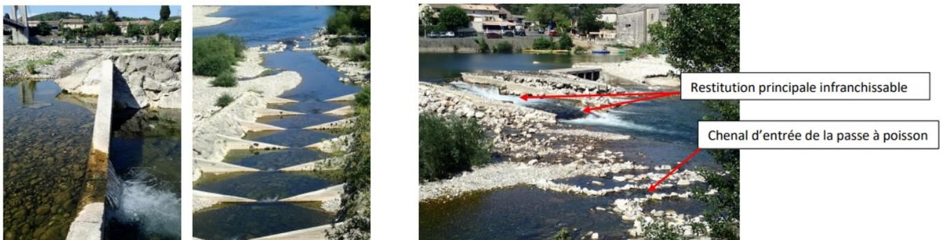
Figure 2 : De gauche à droite : Sortie de la passe à poissons / Vue générale de la passe depuis l'amont / Vue principale de l'entrée de la passe à poissons et de la principale restitution du seuil infranchissable.
