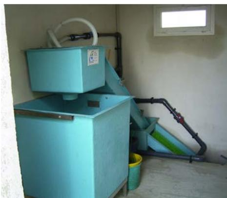
Au fond du bac de capture, un système de vidange obturé par une grille permet d'évacuer l'eau tout en conservant les anguilles. Ce système est une sécurité qui évite les débordements. Une fois le bac vidangé, les anguilles sont capturées manuellement par l'intervenant.
