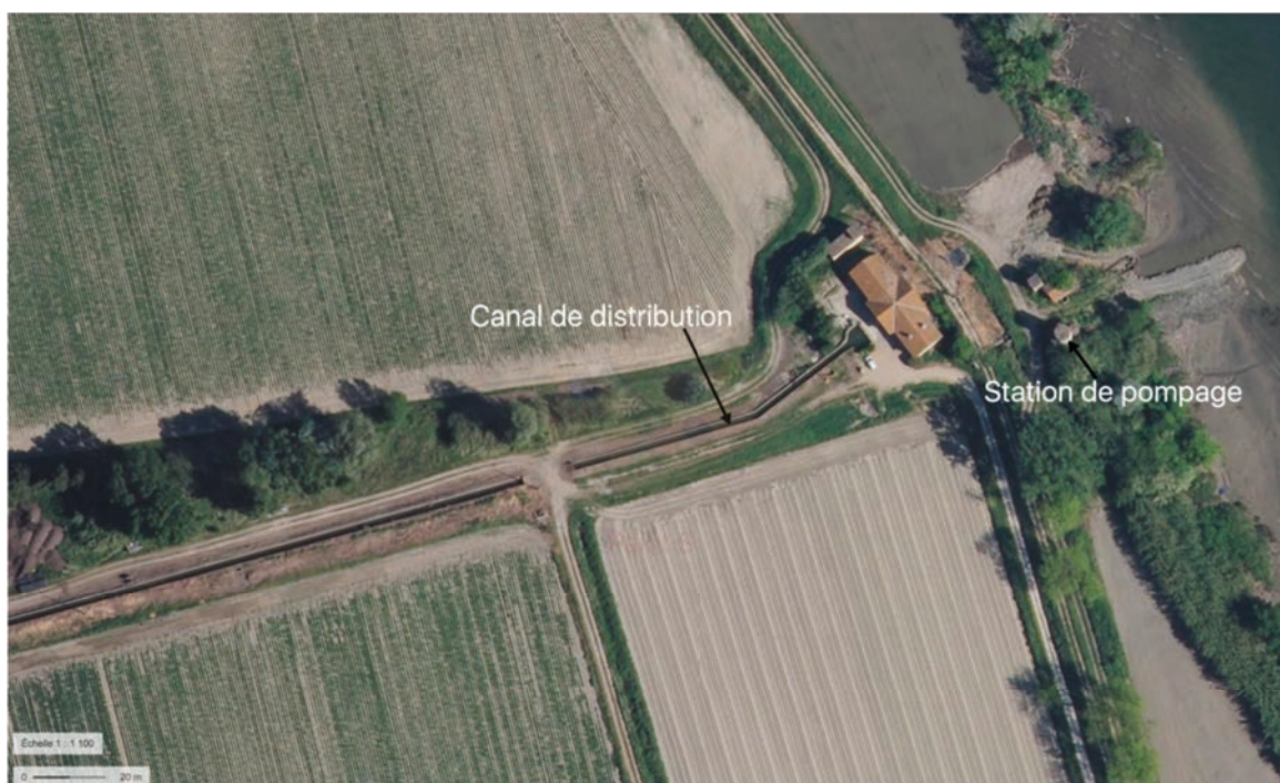
Figure 3 : Vue aérienne de la station de pompage du Sambuc (Source : Geoportail)
