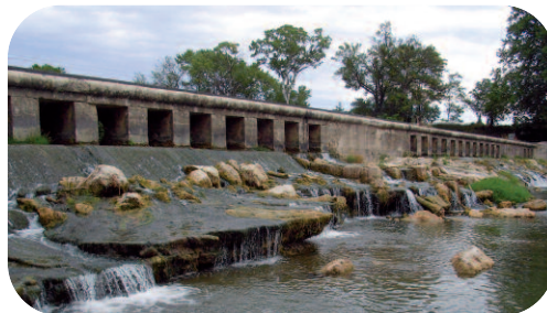
Pont submersible de Villetelle (Vidourle) Franchissabilité 3/5 © Association MRM. 2008
