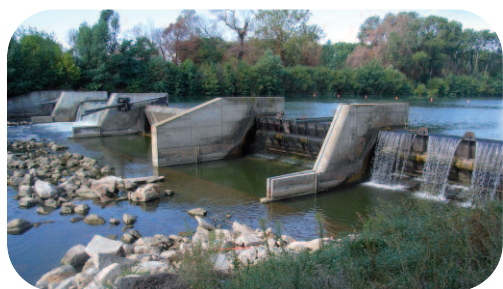
Barrage de Pont rouge (Orb) Franchissabilité 4/5 © Association MRM. 2008
